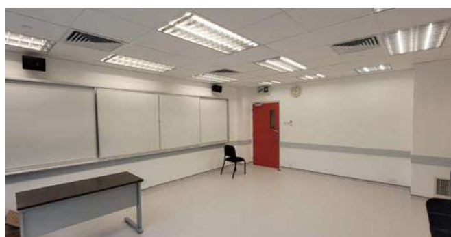
Classroom renovation (completed). 課室翻新工程（已完成）。
